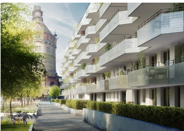
Auf dem Eisring-Süd-Areal direkt beim Wasserturm werden auf vier Bauplätzen rund 550 Wohnungen, ein Supermarkt, ein Kindergarten und Grünflächen geschaffen.
