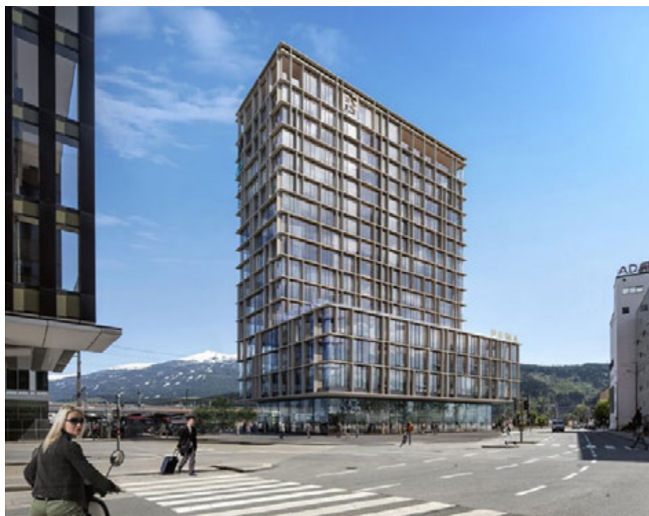
Der 48 Meter hohe Gebäudekomplex „P3“ in Innsbruck mit Büros, Retailbereich und Motel One soll im Sommer 2022 fertiggestellt werden. / The 48-metre-high “P3” building complex in Innsbruck, with offices, a retail zone and a Motel One should be completed in summer 2022.
