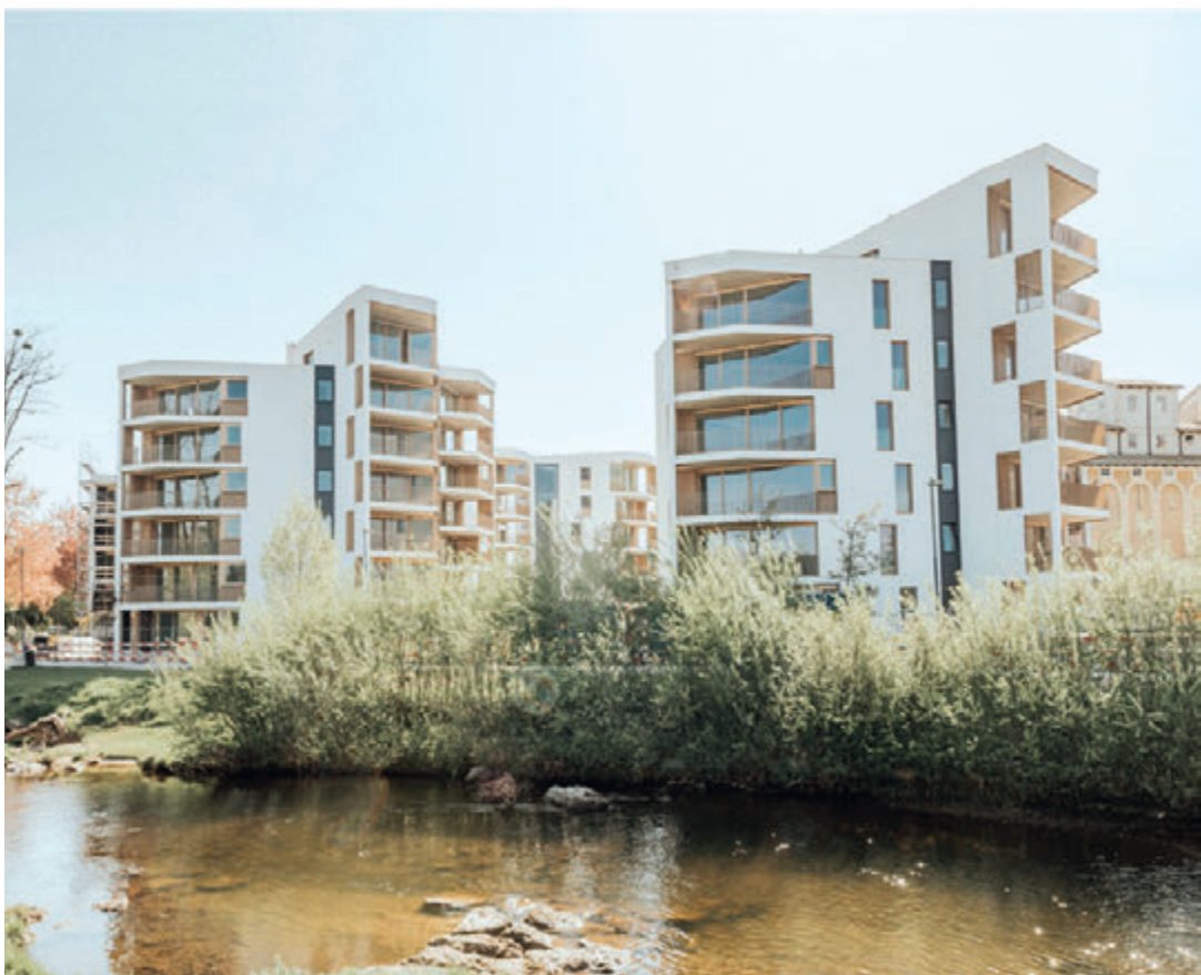
In Salzburg entstehen im Industrieensemble der alten Rauchmühle neue Büroräume und Wohnungen. New offices and apartments are being built in the “Alte Rauchmühle” industrial ensemble in Salzburg.
