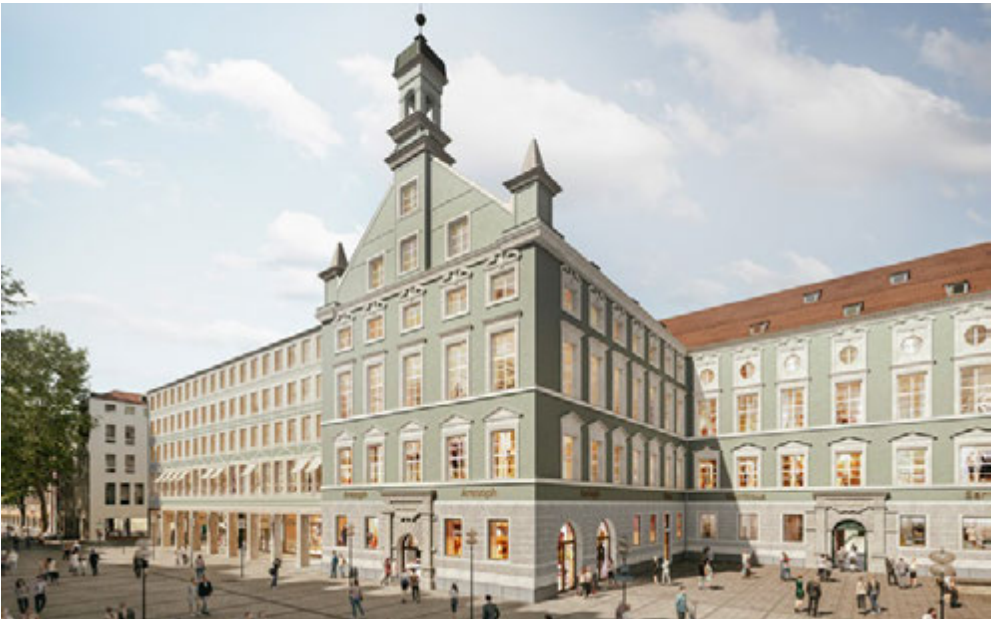
Bis 2023 wird die Alte Akademie in der Münchner Innenstadt revitalisiert. The Alte Akademie in downtown Munich will be revitalised between now and 2023.
