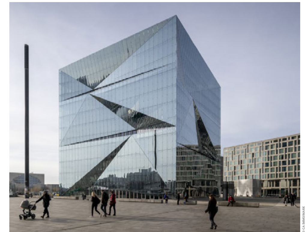
CA Immo hat das Bürogebäude cube berlin nach knapp drei Jahren Bauzeit fertiggestellt. CA Immo has completed the cube berlin office building after almost three years on site.
